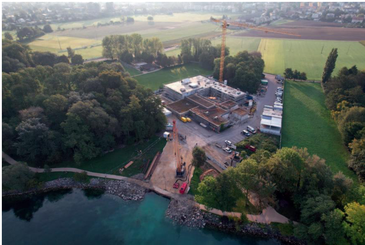
Abb. 1: Drohnenansicht der Baustelle des Seewasserwerks Ipsach. Datum: 01.10.2022
