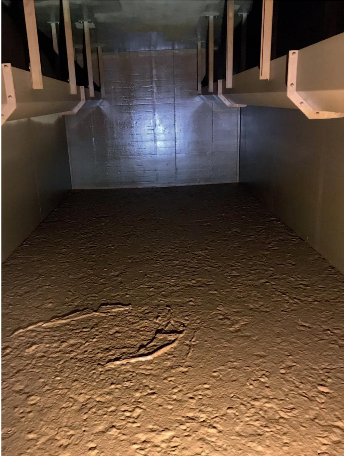
Abb. 8: Blick in die Filterkammer eines beladenen Filters
